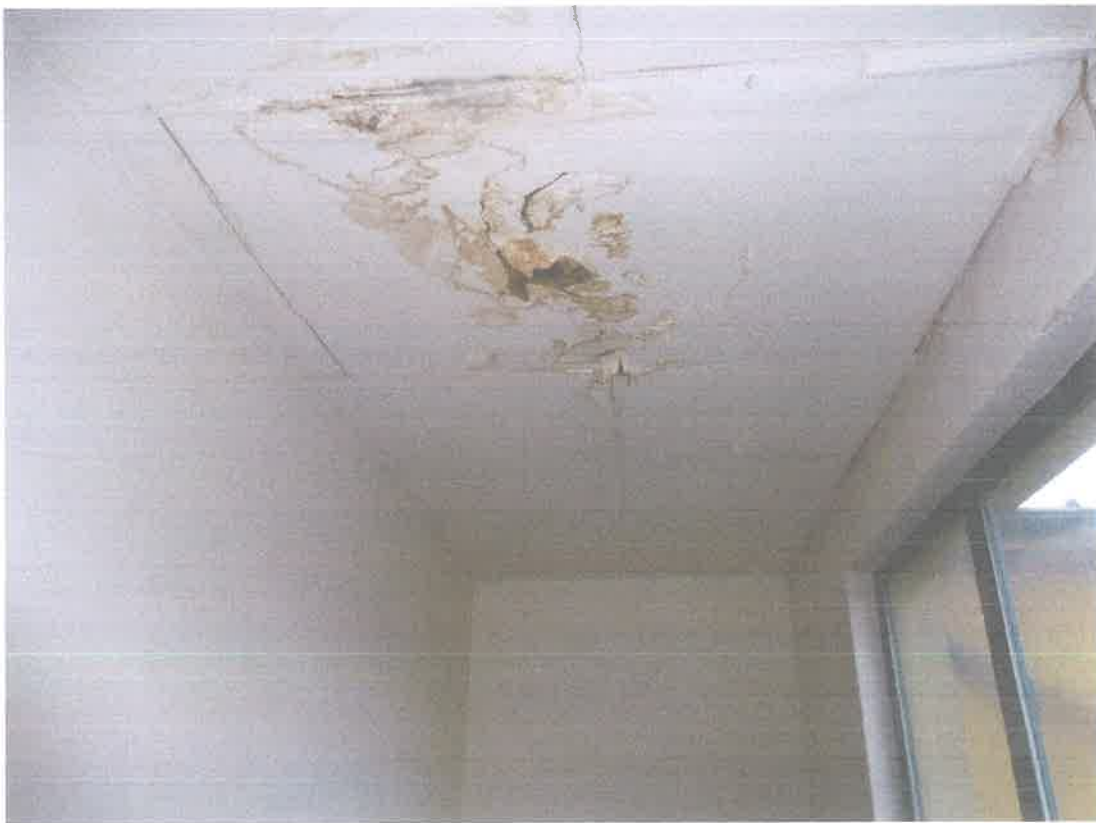
2. NP – poškozený pohled v prostoru schodů z výrobních hal v 1. NP
