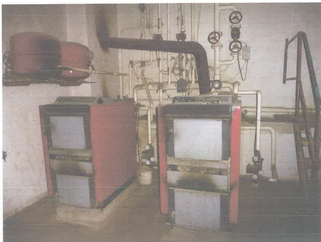
1. NP – kotelna - kotle na dřevěné brikety
